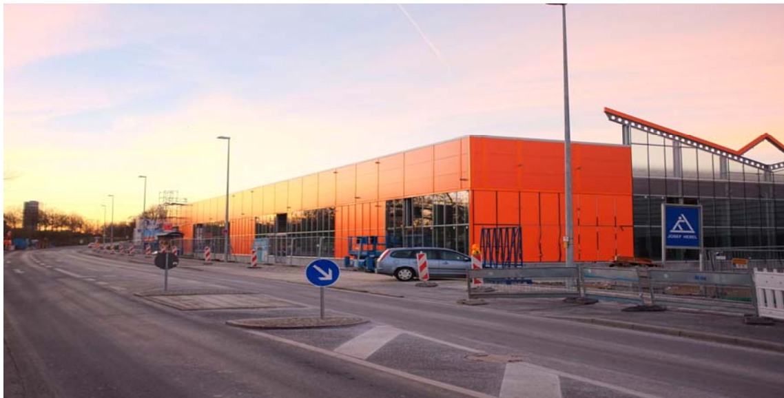
Ansicht von Süden, Gartenmarkt und überdachte Freiverkaufsfläche
