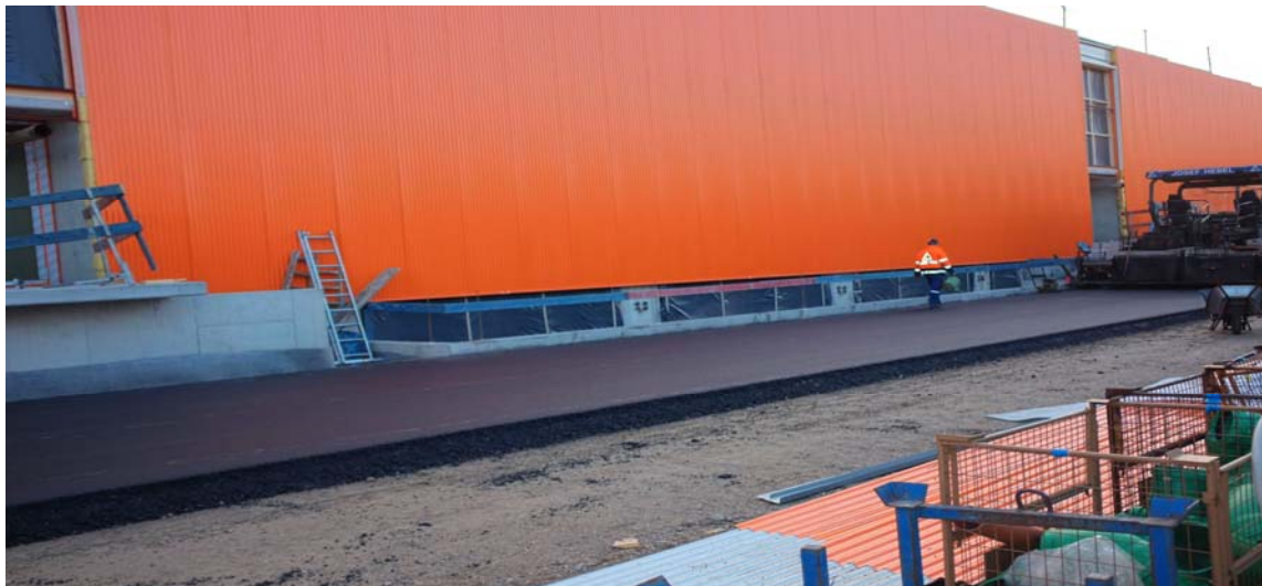
Kellerschächte und LKW-Umfahrt im Norden.
