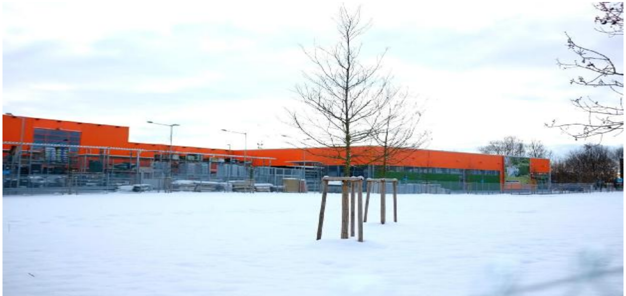
Foto 7: Eingehauste überdachte Freifläche, Westseite
