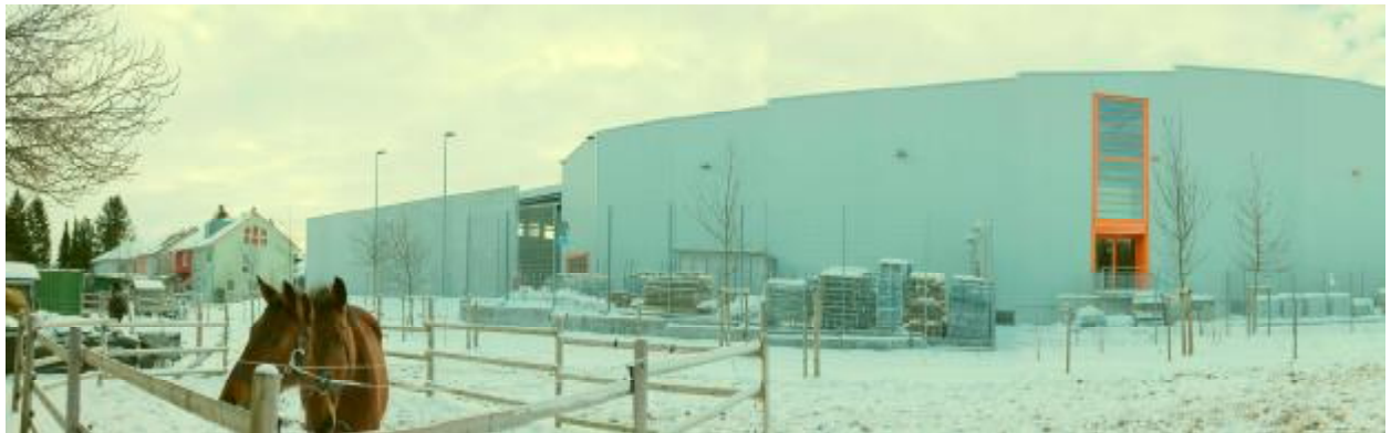
Foto 5: Nordansicht Richtung Osten
