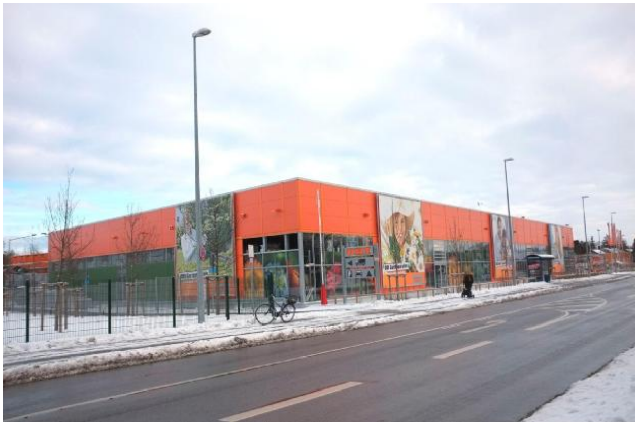
Foto 7: eingehauste überdachte Freifläche, Südwestseite
